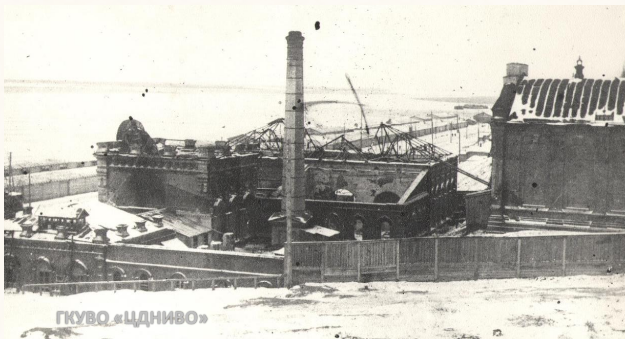
Разрушенная водоканка, г. Сталинград. 1942 г. // ЦДНИВО. Ф. 914. Оп. 1. Д. 92. Л. 12.
