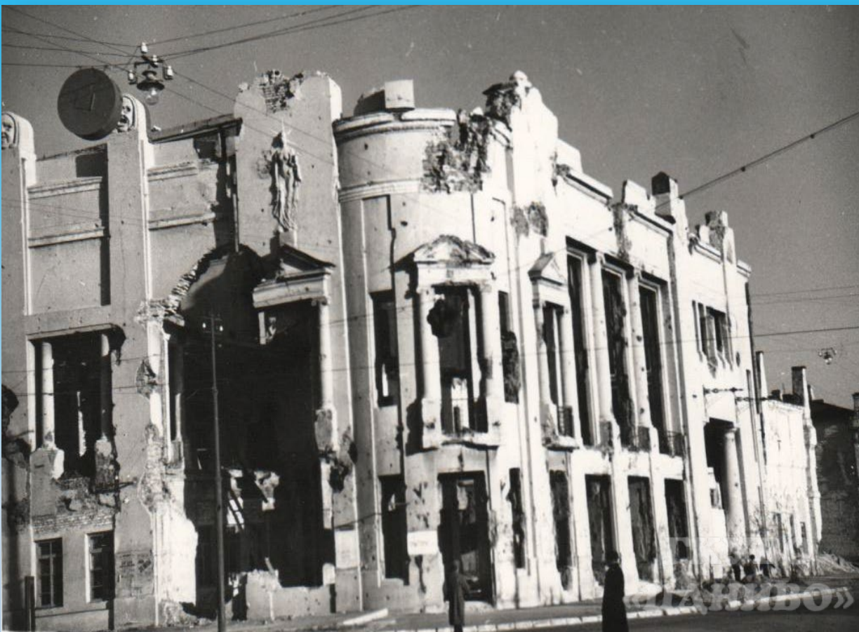
Разрушенный ТЮЗ (ул. Октябрьская, 16) 1943 г. / Ф. 13226. Оп. 1. Д. 2922. Л. 1.
