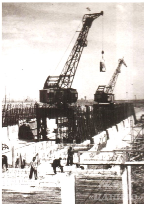
Строительство Волго-Донского судоходного канала им. Ленина Сталинград, 1949 г. / ЦДНИВО. Ф. 914. Оп. 1. Д. 99. Л. 10.
