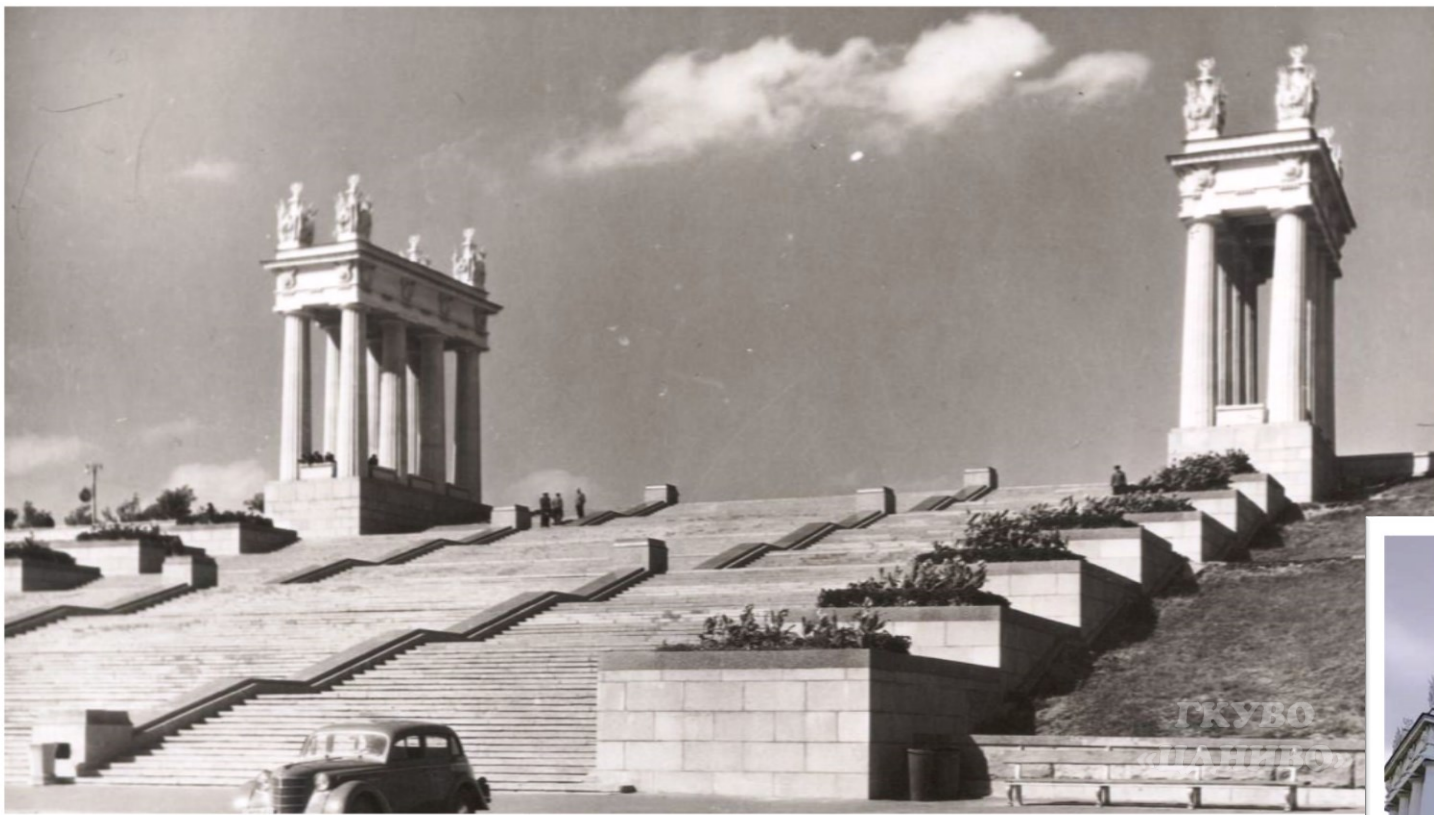
Центральная лестница Набережной Сталинград, 1959 г. / ЦДНВО. Ф. 13226. Оп. 1. Д. 1047. Л. 8.
