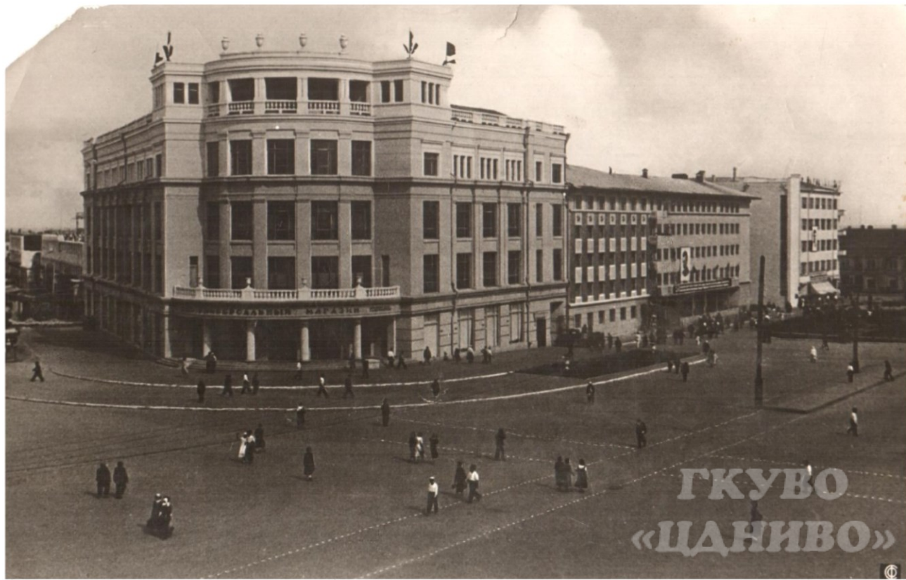
Ф. 13226. Оп. 3. Д. 103. Л. 1. Центральный универмаг в г. Сталинграде
